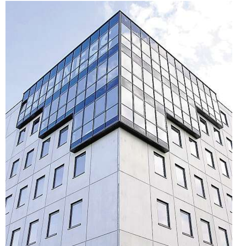
Das Gebäude mit der gestaffelten Glasfassade ist schon von Weitem zu sehen.
